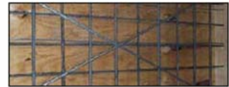
Before concrete pour
